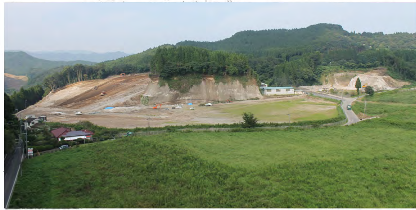
宮崎県高原町に建設中の「天照太陽光発電所」
